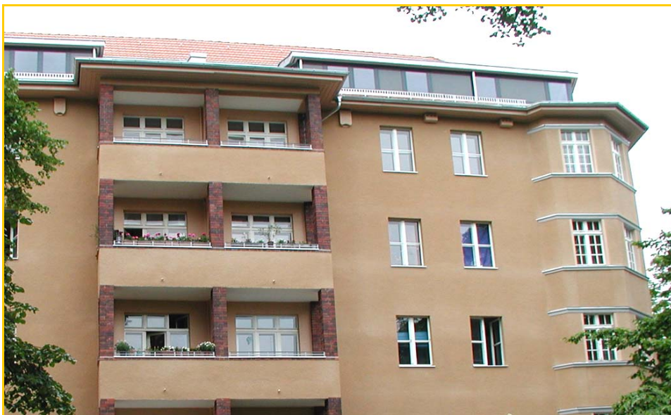
Anbringung von Fledermausfassadenquartier FQ, Fledermausganzzjahresquartier WQ und Sperlingskolonie 1SP an einem Sanierungsobjekt der GEHAG, Laubacher Str. 56 in Berlin-Wilmersdorf.
