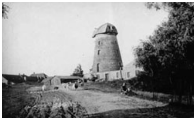
Sie wurde 1925 vom neuen Besitzer zum Aussichtsturm umgebaut, der die Flügel für eine Aussichtsplattform abnehmen ließ.
