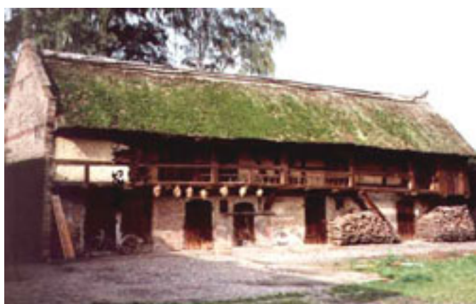
Heute noch erhaltener und restaurierte denkmalgeschützter Laubengang-Stall in Michendorf.
